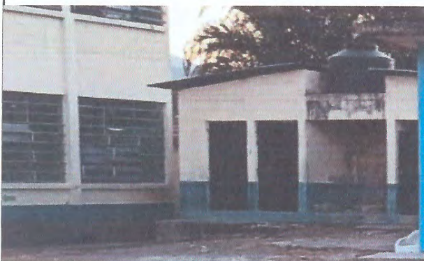
Foto 3: MANTENIMIENTO CISTERNA/DEPOSITO DE AGUA
